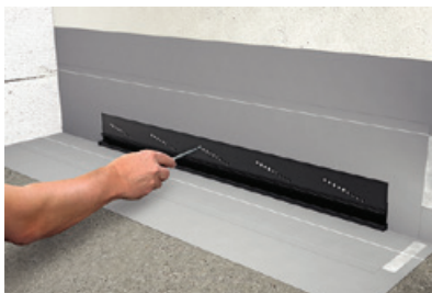
Ilustr. 3 – 31 Odpływ ścienny – kołnierz uszczelniający
