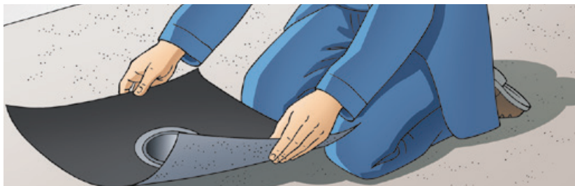
Ilustr. 3 – 19 Ułożenie maty uszczelniającej
