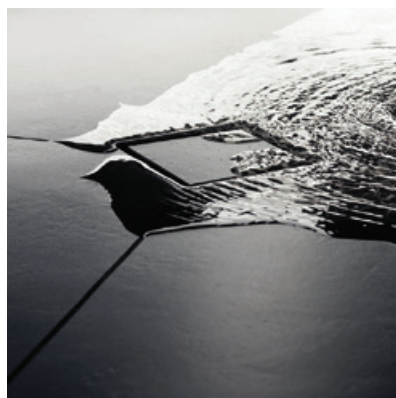
Ilustr. 3 – 2 Odpływ w obiekcie użyteczności publicznej
